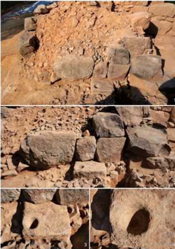
동문지 문구부 북측 전경(1번 전경, 2번 근경, 3번, 4번 문확석 세부)
