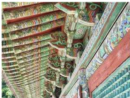
안동 광흥사 응진전 정면 공포부
